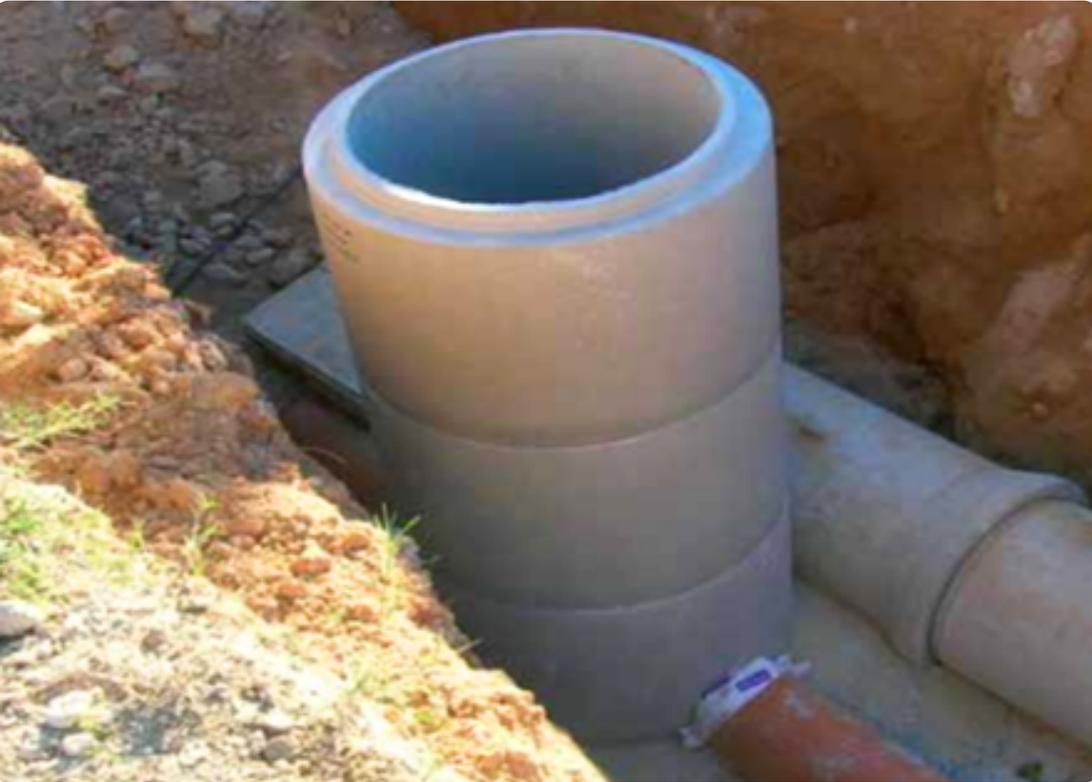
Los buzones de Entrepisos Lima se fabrican bajo la Norma Técnica Peruana NTP 239.702-2017 CONCRETO. Buzones de alcantarillado de concreto prefabricado y reforzado, cumpliendo los requisitos de materia prima, dimensiones y procedimientos que requieren las especificaciones locales.
